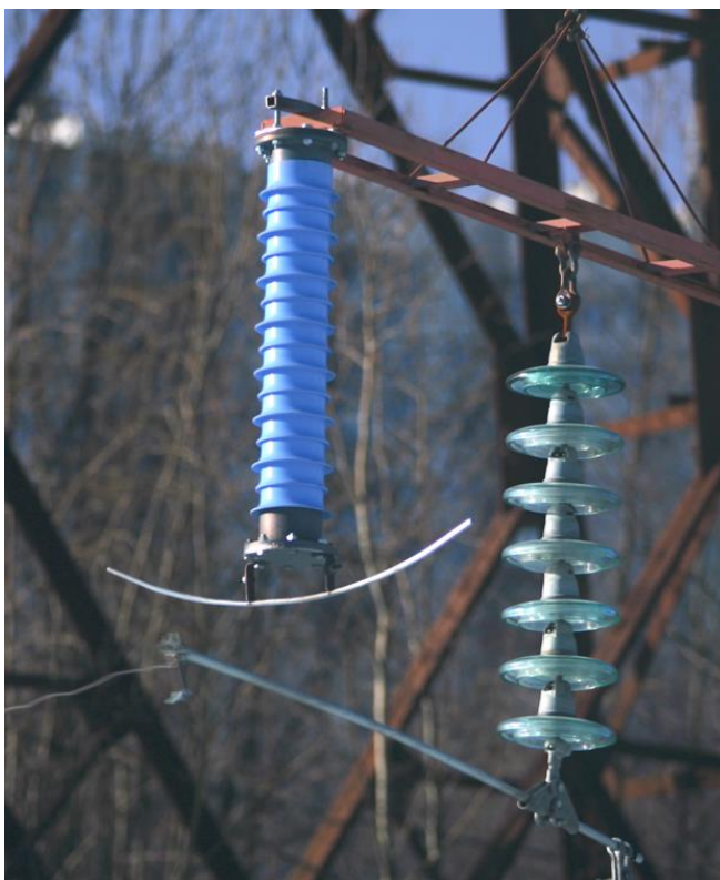
Рисунок 7 – Проведение испытаний одноминутным переменным напряжением.
